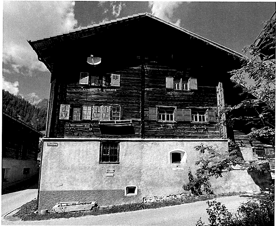
Abbildung 2 - Wohnhaus mit gemauertem Sockel und gestricktem Oberbau
