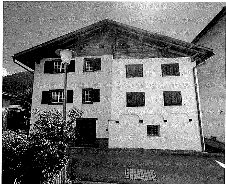
Abbildung 3 - Wohnhaus in Massivbauweise mit gestricktem Giebeldreieck
